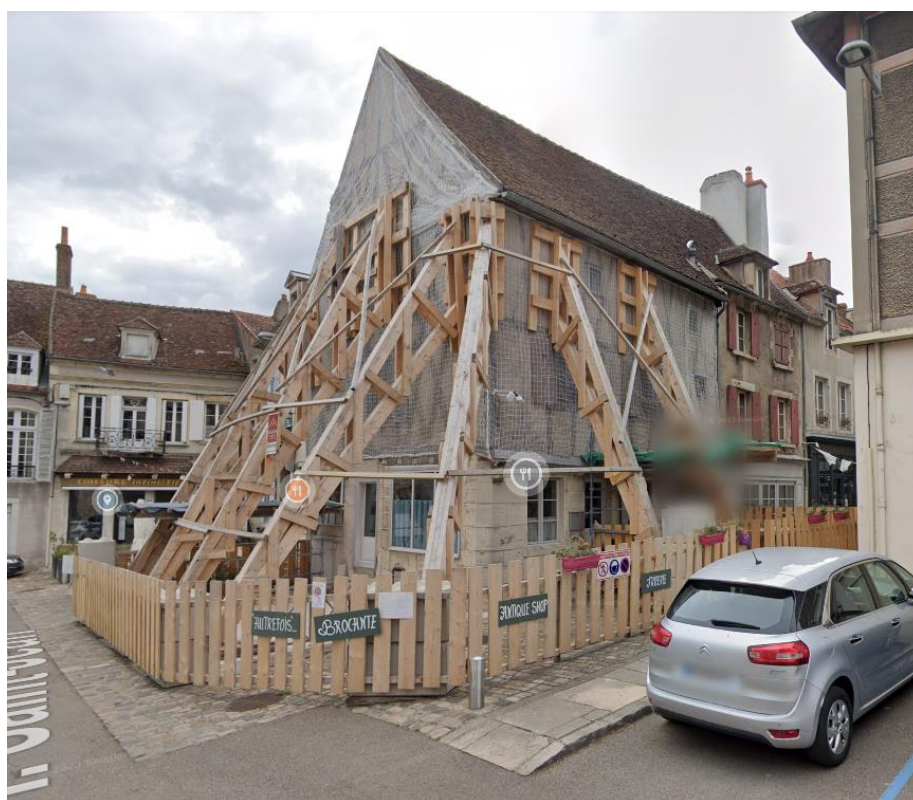
Figure 1 – Photographie actuelle Maison DANJEAN Marcelle par suite de la confortation provisoire d'urgence mise en place
